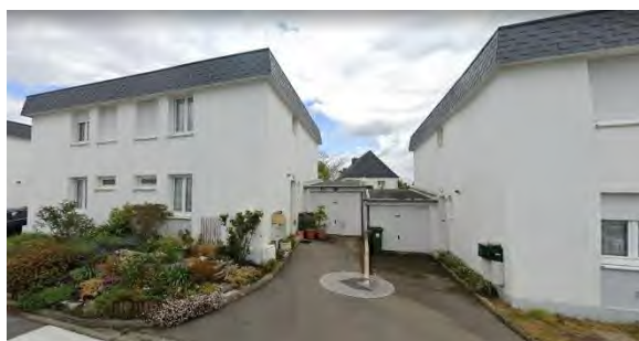
PLUVIGNER (56) Résidence La Croix Courte 30 logements
