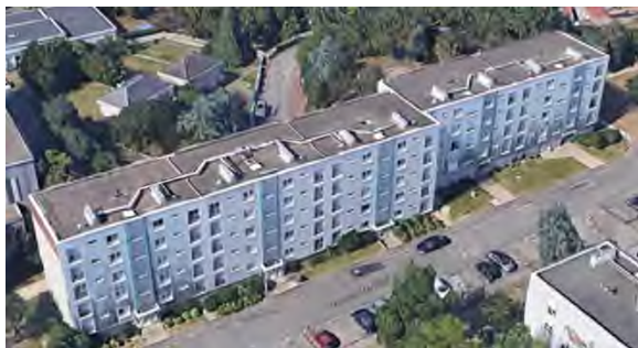
ST HERBLAIN (44) Résidence Moulin du Bois 46 logements
