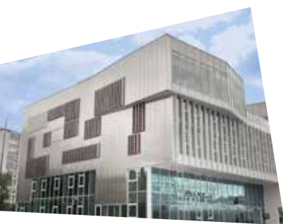
L'Atrium, le siège social à Nantes.
